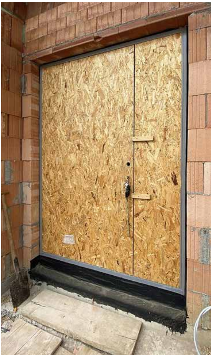
Een bouwdeur met eenvoudig slot sluit in de nieuwbouw provisorisch de ingang, totdat de huisdeur is gemonteerd. Bouwdeuren levert Finstral optioneel af fabriek.
