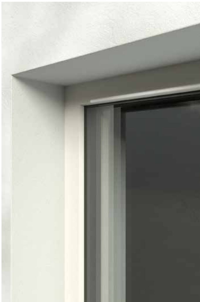
zichtbare montage van het kozijn
