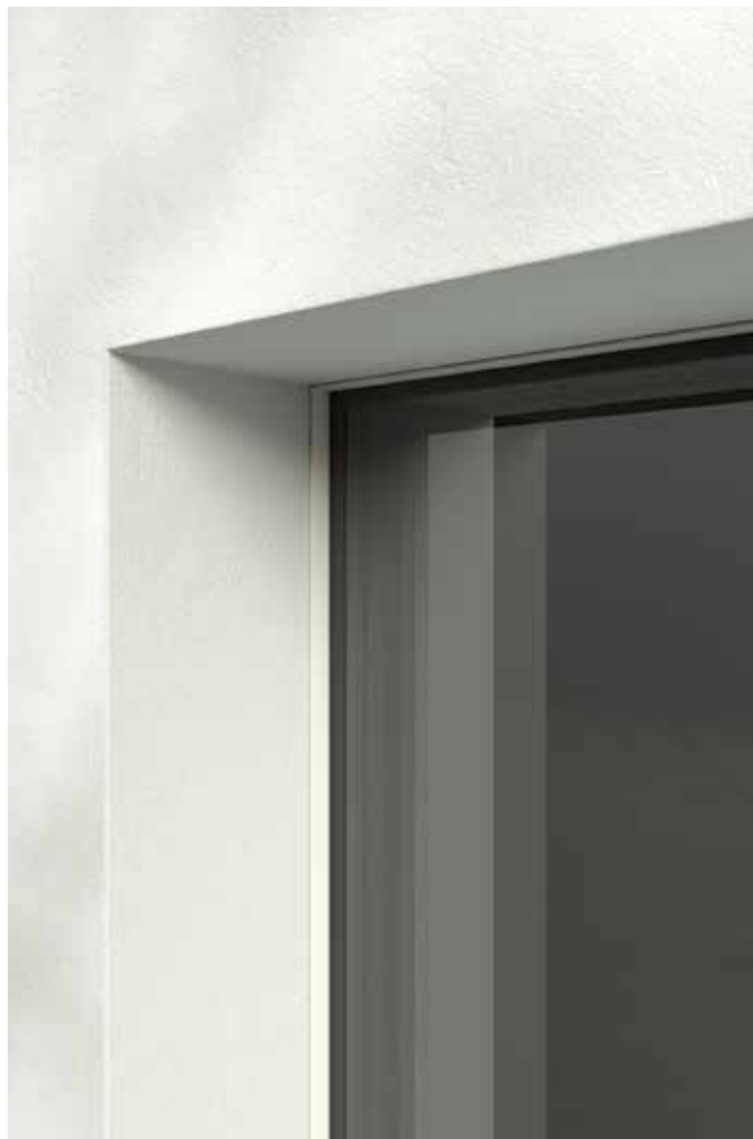
verdektliggende montage van het kozijn
